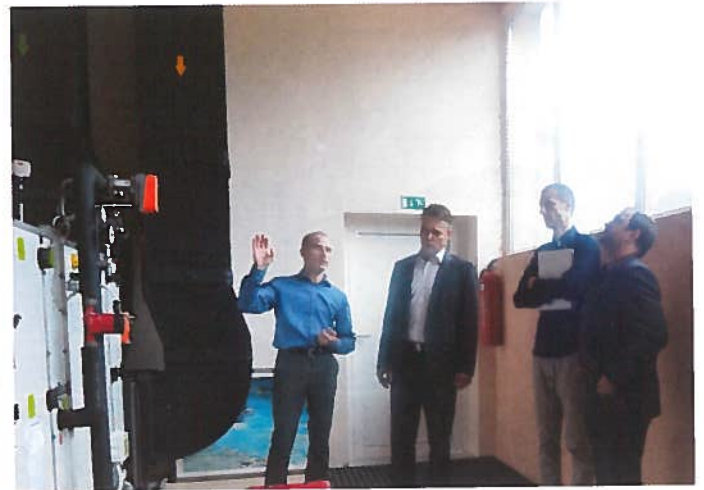
Menjave vira ogrevanja v sklopu energetske prenove na stavbi v lasti javnega sektorja, vir: Neva Jejčič
